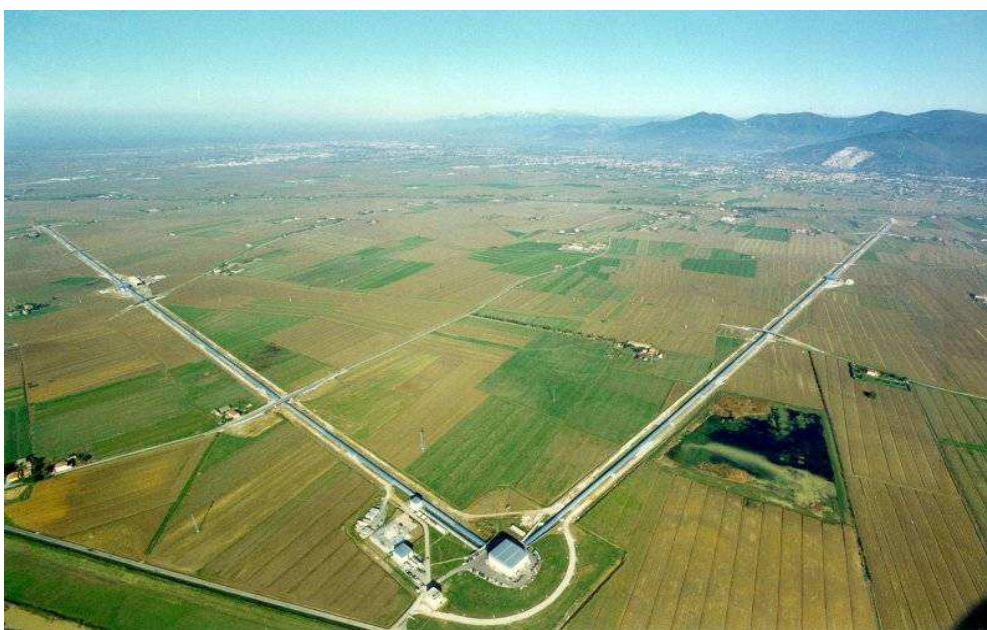
Obr. 4 Italský laserový interferometr VIRGO (Pisa, 2003), délka každého z ramen je 3 km
