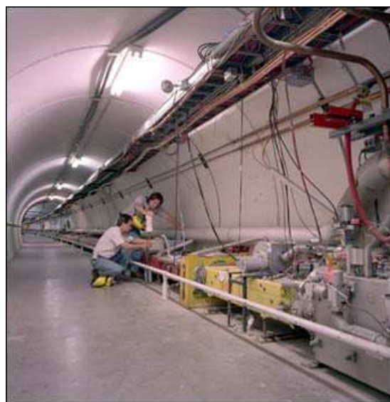
Obr. 3 Vnitřek urychlovací trubice
