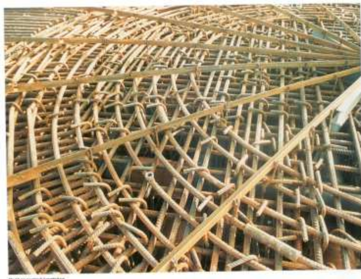
Montáž vrchlíku kontejneru
