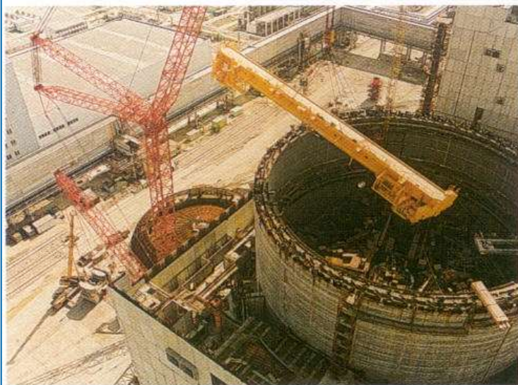
Montáž vrchlíku kontejneru
